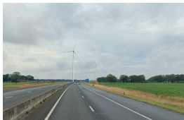
A35 t.h.v.t viaduct Leemslagenweg
